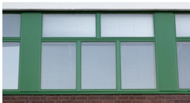
Rastaalan koulu, valkolakattuja ikkunoita, joissa ulkoväriä neljää sävyä ja ikkunoissa umpiosat. Ikkuna on 5-osainen yhdessä karmissa.
