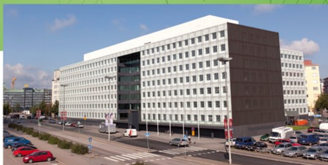
Хаканиеми, Хельсинки, здание Управления по делам образования. 760 окон с солнцезащитными стеклами и серыми рамами.
